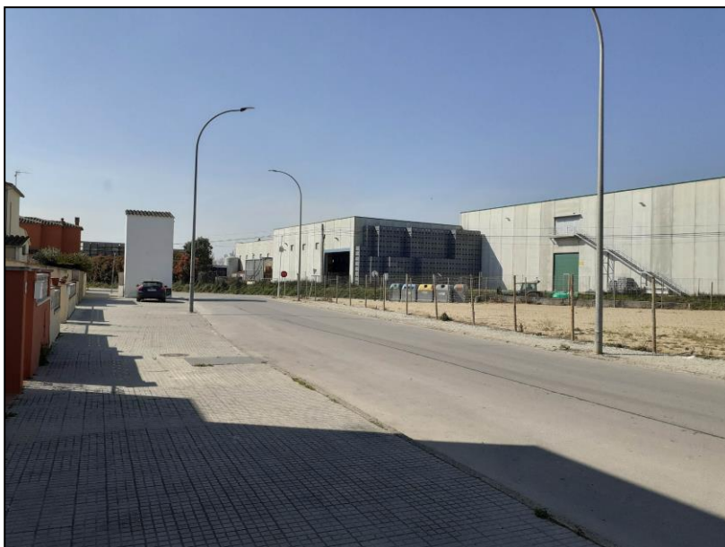
Foto 7. Perspectiva de les naus des del carrer Onze de Setembre a l'altura del carrer Marinada.
