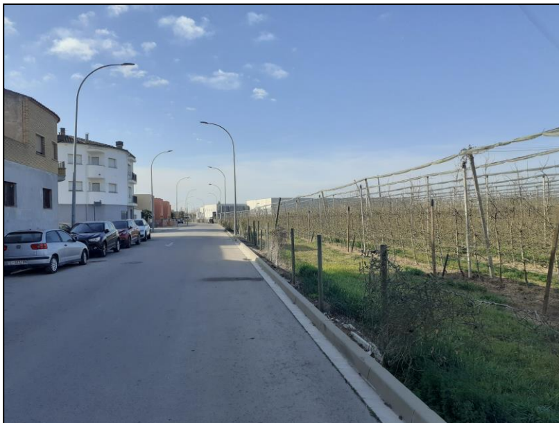
Foto 1. Extrem NE de l'àmbit amb el carrer Onze de setembre en primer terme.
